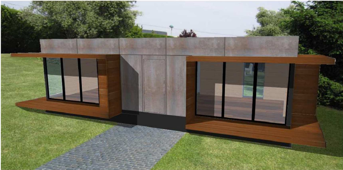
imatge3. Façana principal i accés a l'habitatge amb acabat de GRC amb òxid metàl·lic
