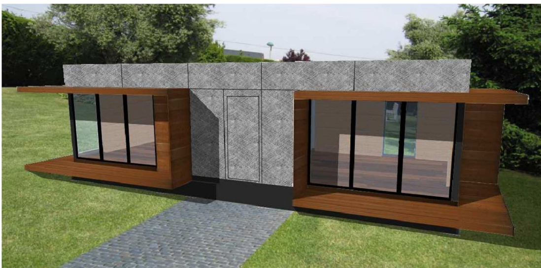
imagen4. Fachada principal i acceso a la vivienda con acabado exterior en GRC texturizado con relieve.
