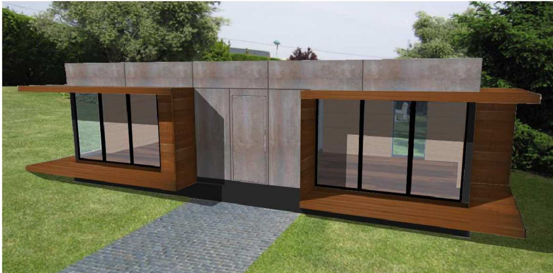
imagen3. Fachada principal y acceso a la vivienda con acabado exterior en GRC con oxido metálico.
